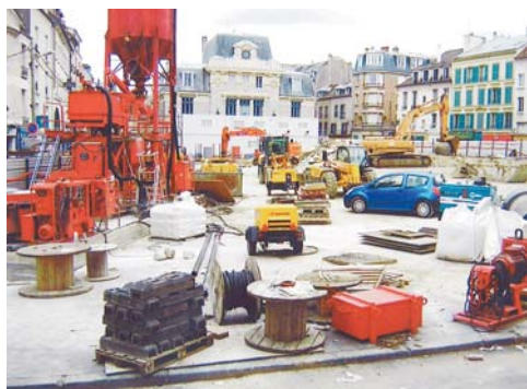
Parking de Saint-Germain-en-Laye, début des travaux, janvier 2005
