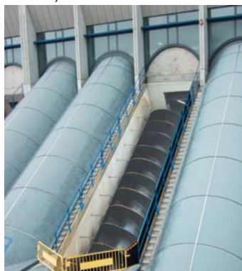
Ci-dessus, les visiteurs sur le site : au centre J.-C. Goas, sur la droite C. Giraud Président de l'ASP (photo du bas). A gauche, les imposantes hélices hélicoïdales transporteuses de remontée des eaux de la station de clarifloculation.
