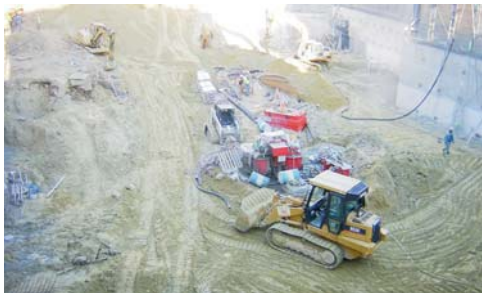
Etat des travaux actuels
