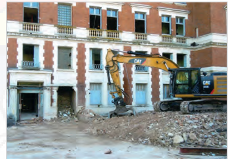
Travaux en cours.
